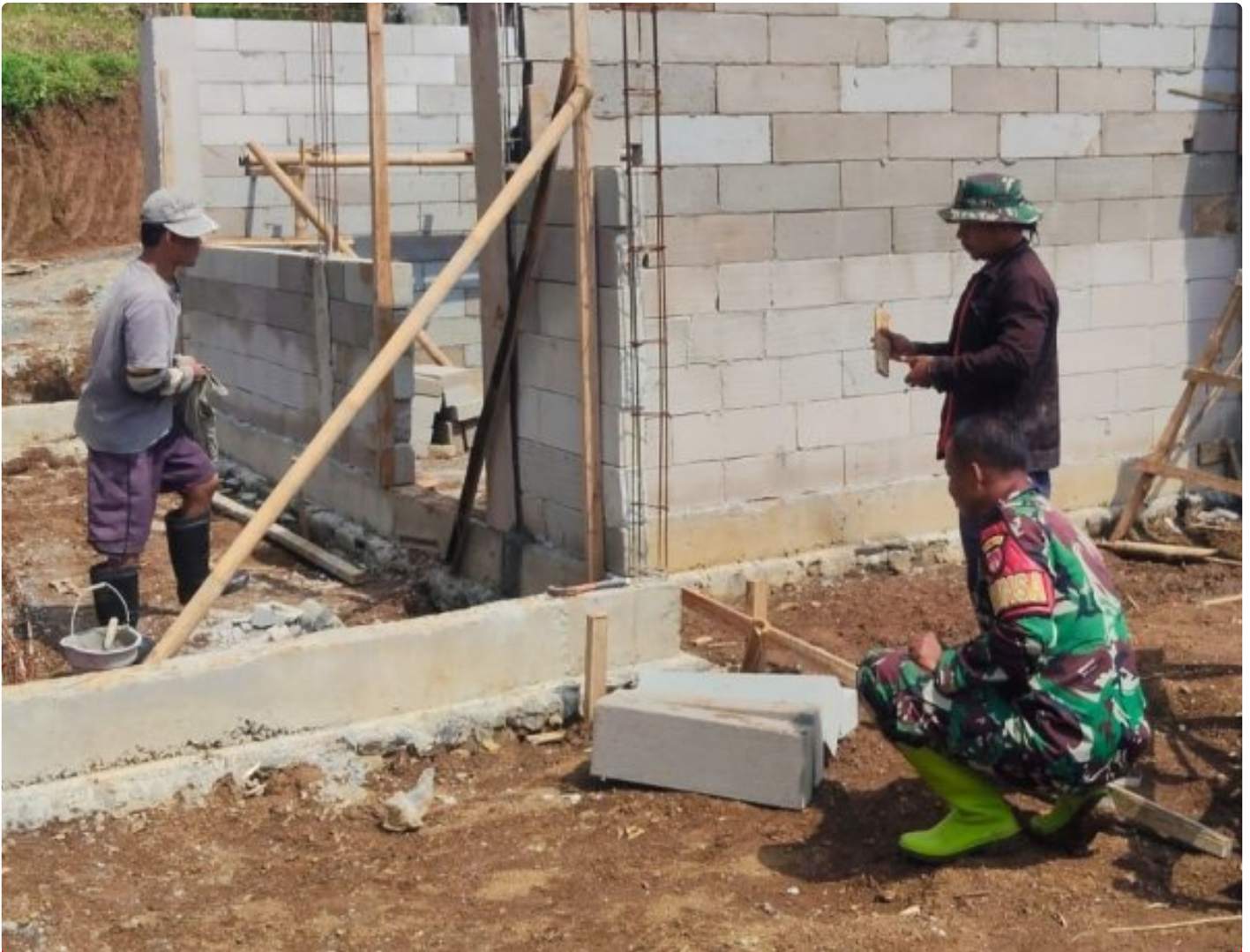
(Foto Dokumen) : Babinsa dampingi pembangunan KDKMP
