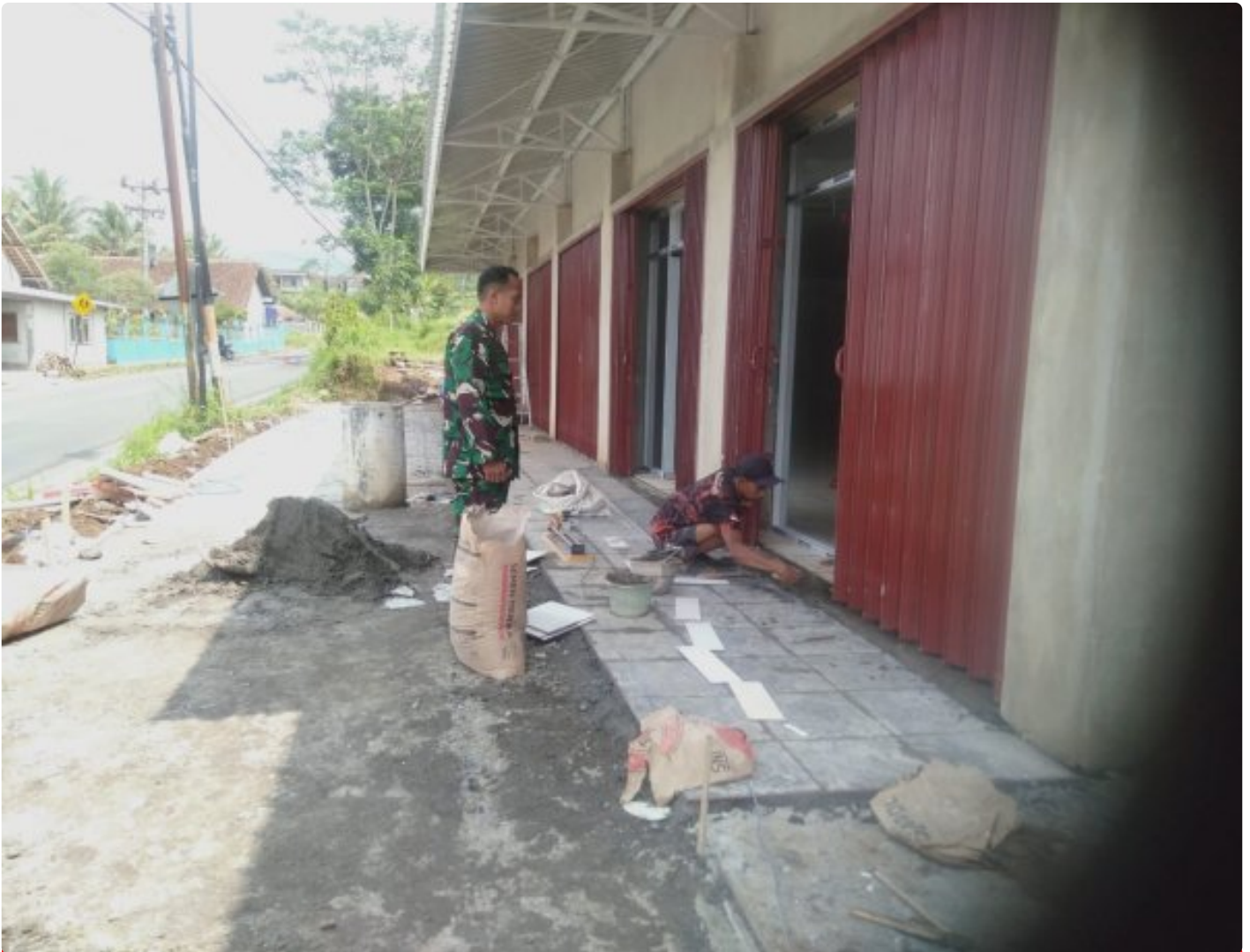
(Foto Dokumen) : Babinsa saat mendampingi pengerjaan pintu gerai KDKMP
